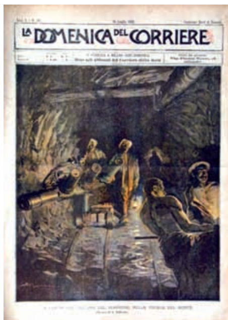
Il traforo ferroviario del Sempione. La Domenica del Corriere gli dedica la copertina. I lavori iniziarono nel 1898 per terminare il 24 febbraio 1905
